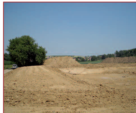
Bassin de rétention
