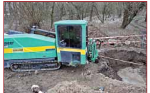
Forage horizontal pour le passage de la conduite d'eau sous la Zorn
