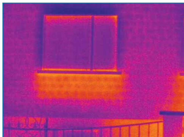
On remarque la présence de radiateur sous la fenêtre.
