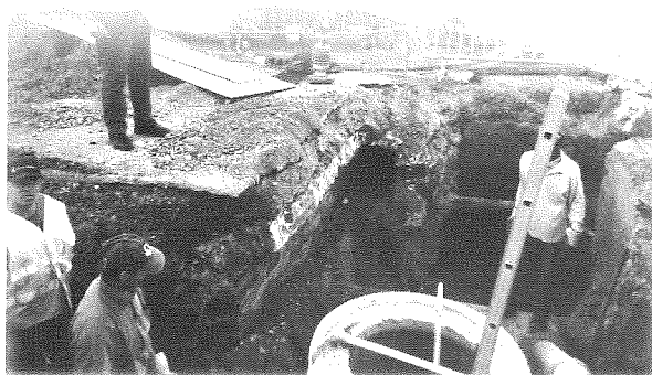
Travaux Rue Hornwerck
